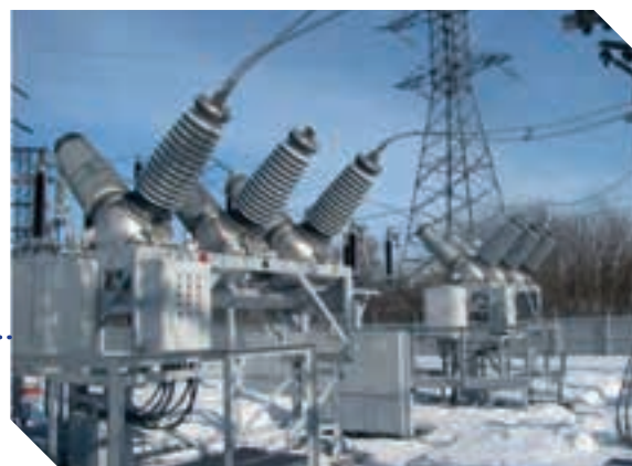
2009 г. Элегазовые баковые выключатели серии ВБ-110
